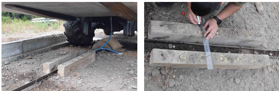
Figura 39 - Montagem e marcação das vigas de madeira com as hastes metálicas
