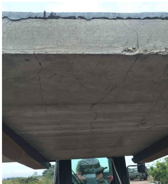
Figura 58 - Laje reforçada com UHPFRC após ensaio
