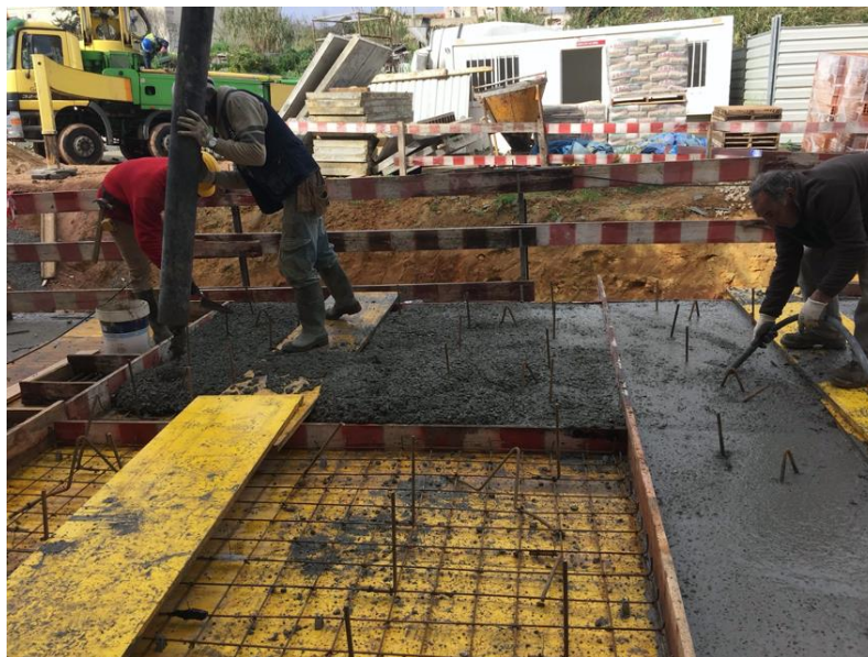
Figura 25 - Betonagem e vibração das lajes
