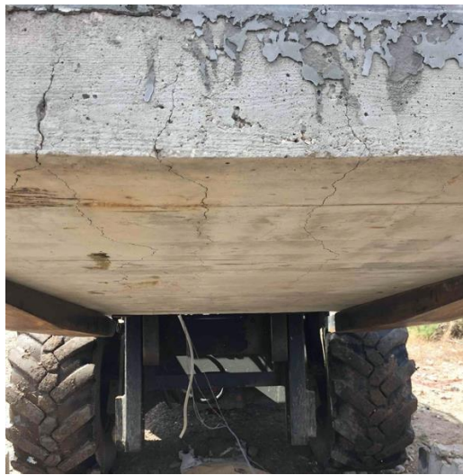
Figura 59 - Laje reforçada com UHPFRC e LWAC após ensaio
