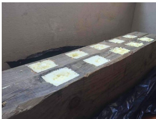
Figura 38 - Viga de madeira com espuma de poliuretano
